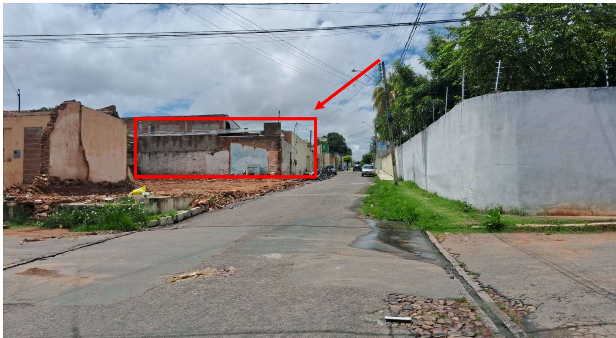
Foto 03 - Parede lateral do imóvel avaliando
