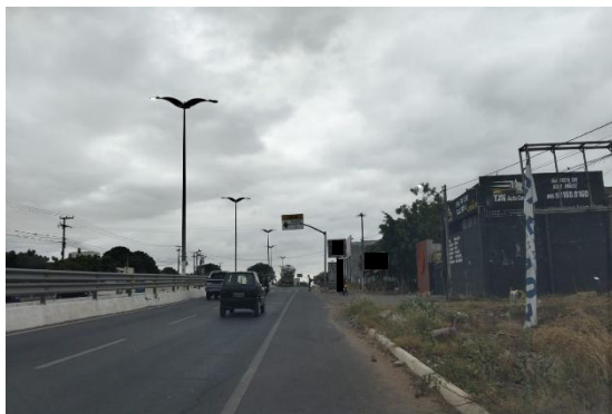
Foto 1 - Vista da Av Leão Sampaio - Rod CE060
