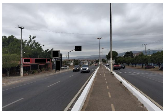
Foto 4 - Vista da Av Leão Sampaio - Rod CE060
