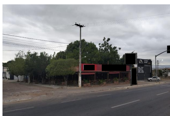
Foto 6 - Vista do imóvel avaliando (Restaurante Cupim na Brasa)
