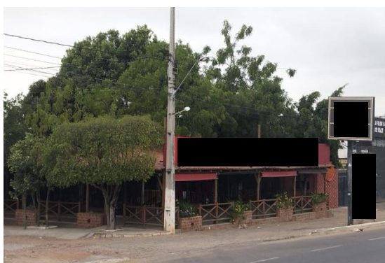
Foto 7 - Vista do imóvel avaliando (Restaurante Cupim na Brasa)
