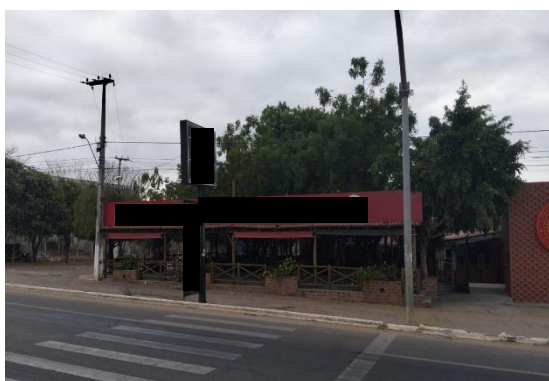
Foto 5 - Vista do imóvel avaliando (Restaurante Cupim na Brasa)
